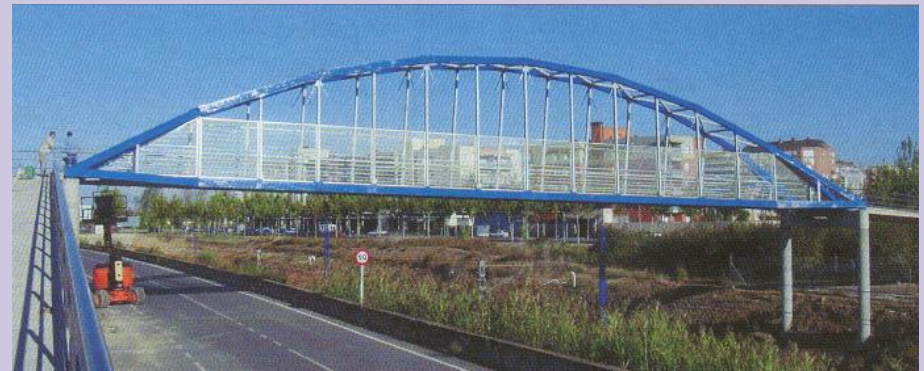
Lleida Bridge (Spain)
