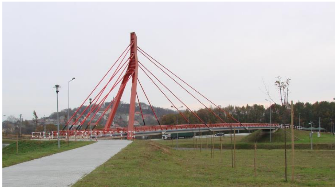
„Krzywy kij” footbridge
