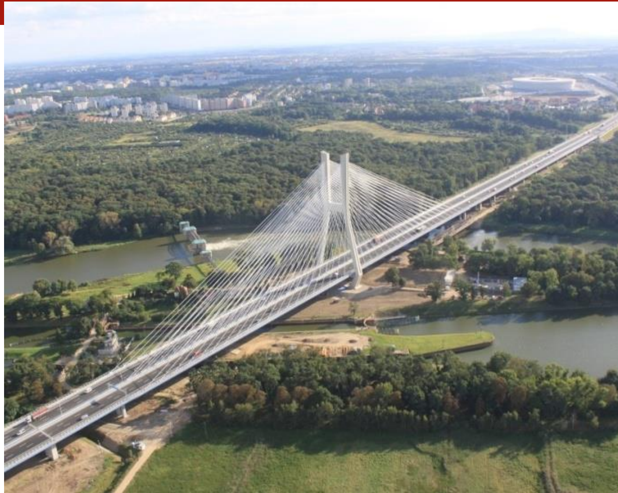
Rędziński Bridge in Wrocław
